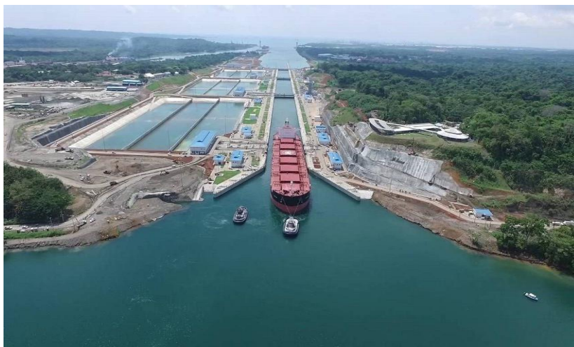
Foto oben: Neue Schleusen mit Ausgleichsbecken, links im Hintergrund die alten Schleusenpaare.
