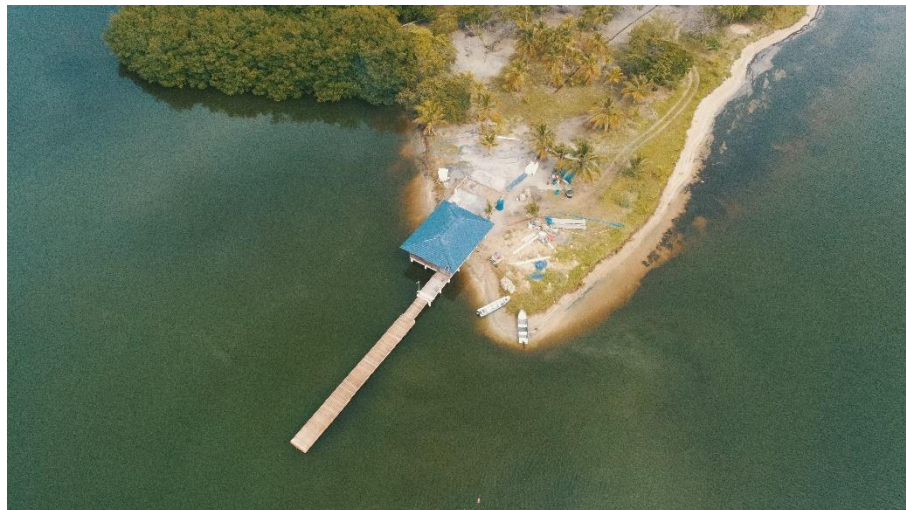
Foto oben: Erste Bauten in der Bahia Escribano.
